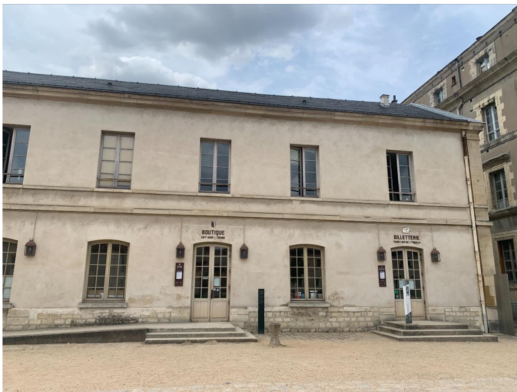
Photographie de la billetterie-boutique.
